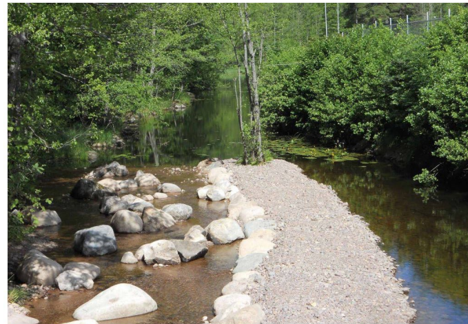
Genomförd åtgärd för fria vandringsvägar i Kisaån, ett omlöp vid Sofidel Swedens anläggning i Kisa.
